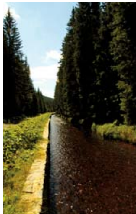
Kanál v úseku nad Antýglem
