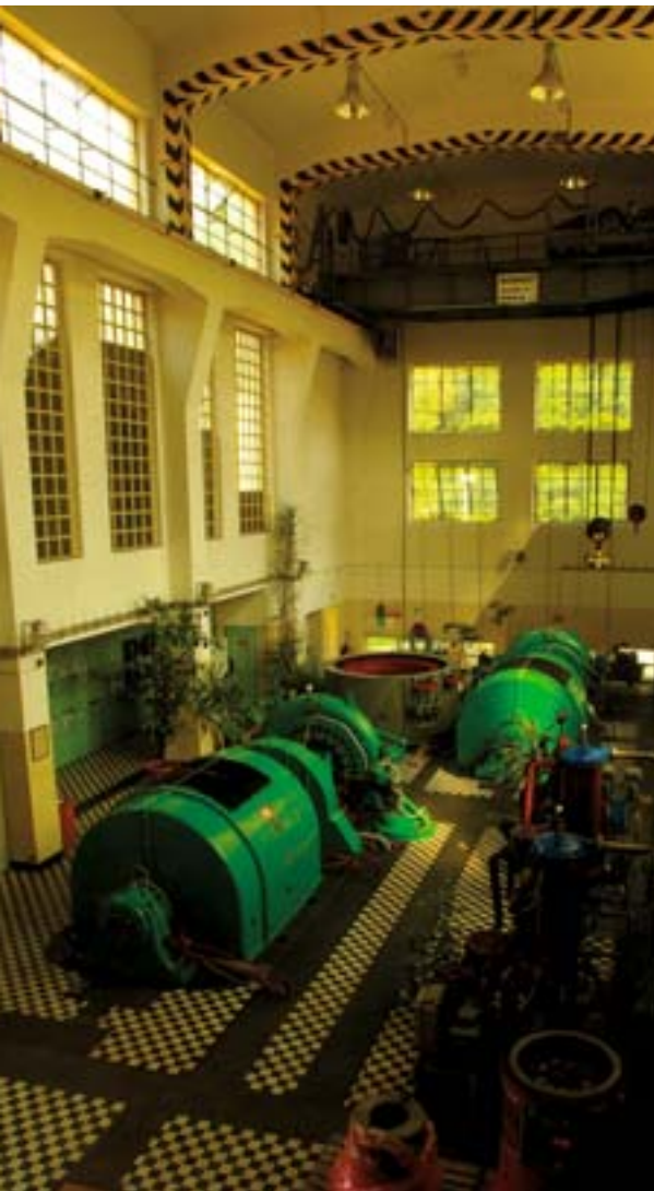
Funkcionalistický interiér elektrárny
