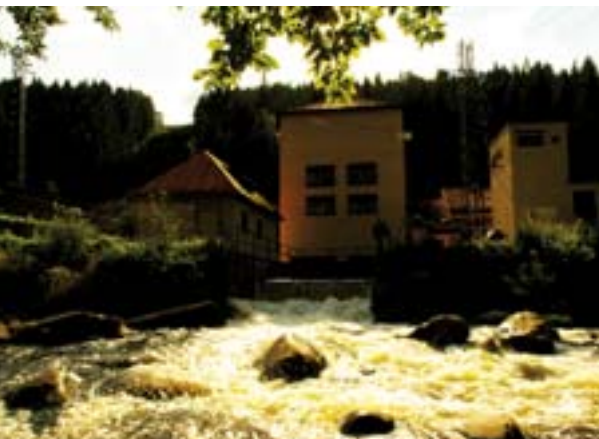
Voda opouštějí turbíny elektrárny Vydra
