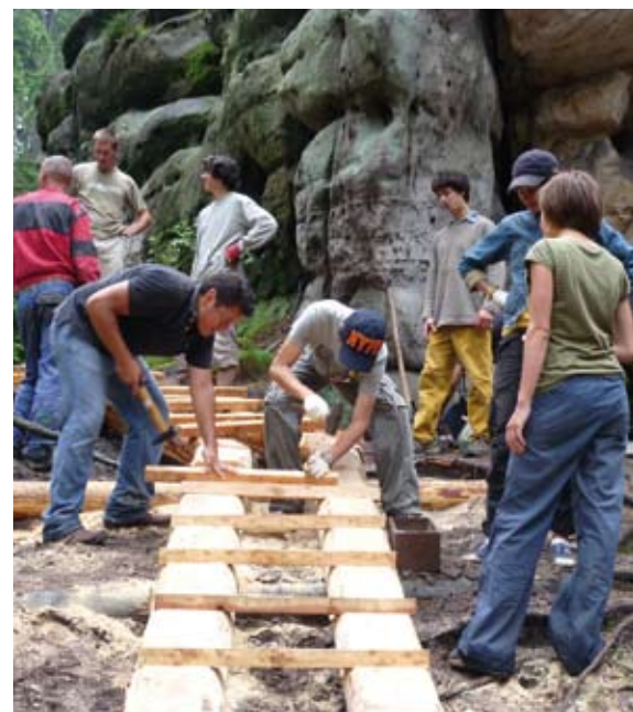
Oprava dřevěného chodníku v CHKO Adršpašsko. Dobrovolníci poznávají prostředí více do hloubky než turisté.
